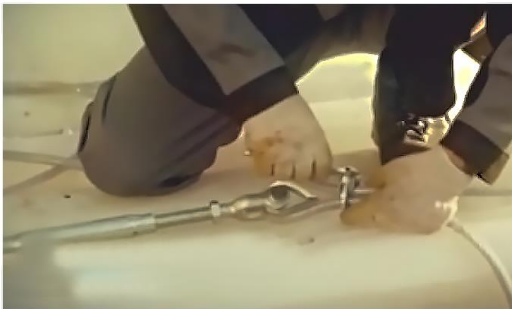
Рисунок 4. Заделка троса.
